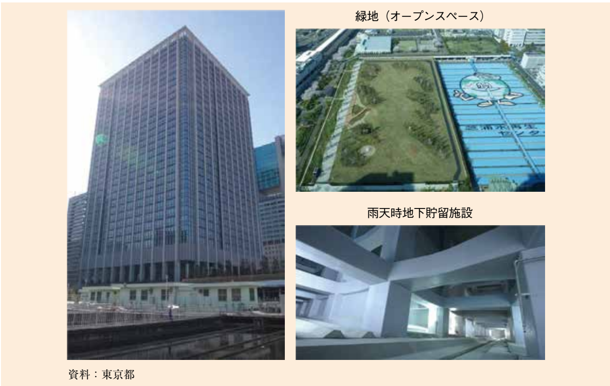
図表2-1-7 品川シーズンテラスと緑地・雨天時地下貯留施設
