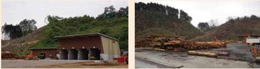
木質バイオマス発電所
