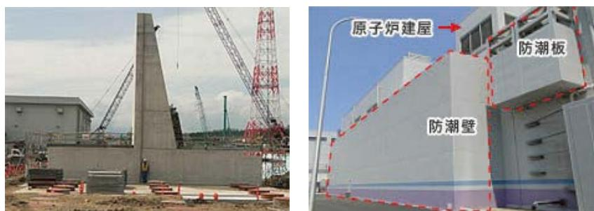
図 1-11 東京電力柏崎刈羽原子力発電所の防潮堤、防潮壁・防潮板
